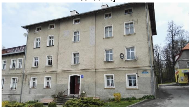
Fotografia: Kamienica mieszkalna przy Pl. Mariańskim
