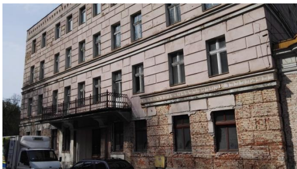
Fotografia: Kamienica mieszkalna przy ul. Kościuszki
