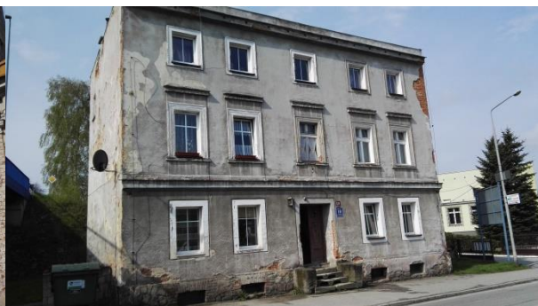
Fotografia: Kamienica mieszkalna przy ul. Kościuszki
