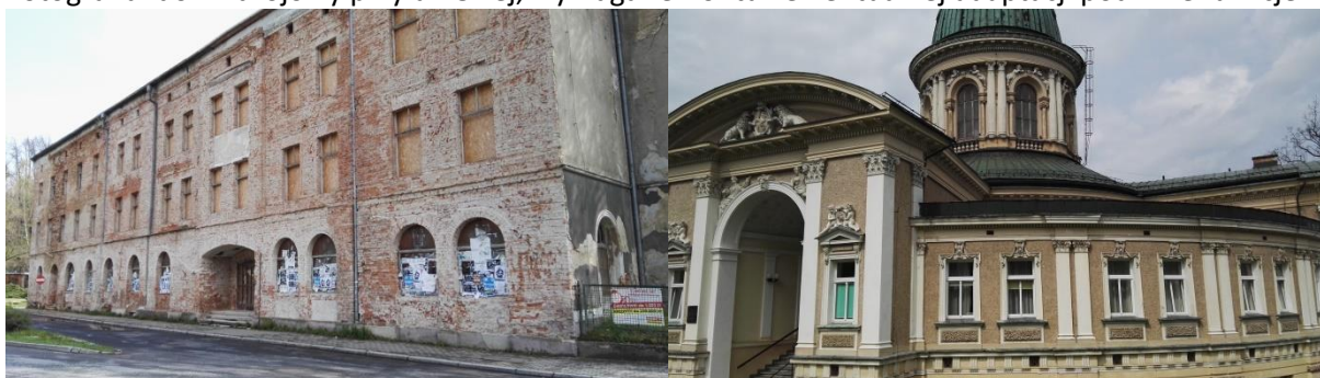
Fotografia: budynek hotelowy w przebudowie przy ul. Skłodowskiej-Curie
