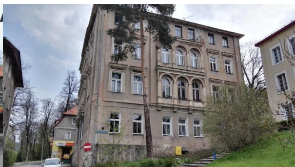
Fotografia: Kamienica mieszkalna przy Pl. Mariańskim
