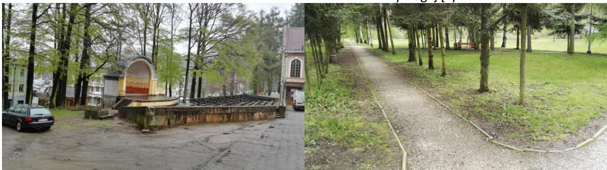
Fotografia: Przestrzeń publiczna i muszla koncertowa przy ul. Orlej i Cienistej, wymaga modernizacji i remontu
